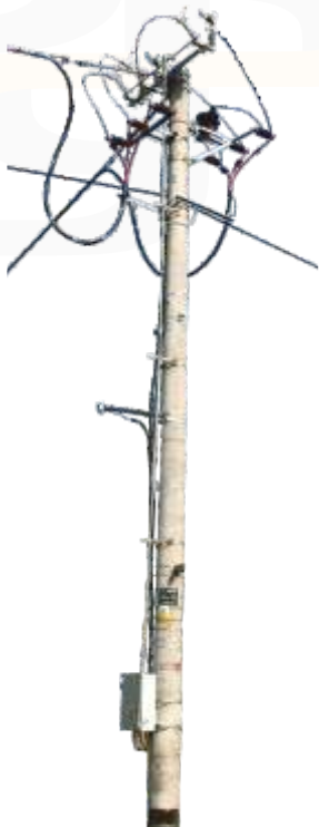
Stanowisko słupowe sterowane zdalnie
