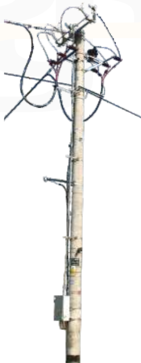
Stanowisko słupowe sterowane zdalnie
